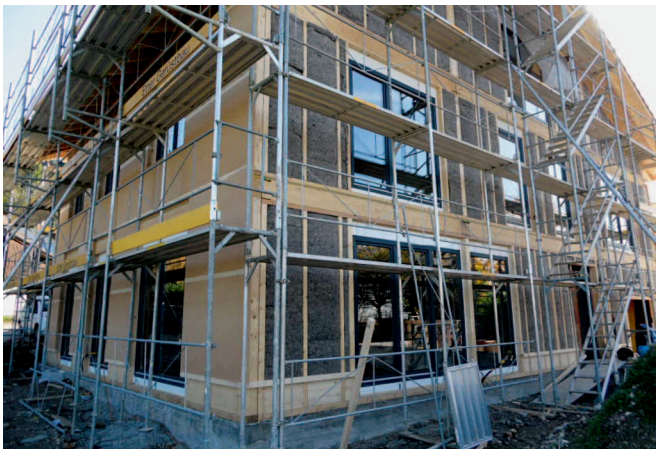
Der «Pullover» des Hauses dämmt und nimmt Feuchtigkeit auf.
